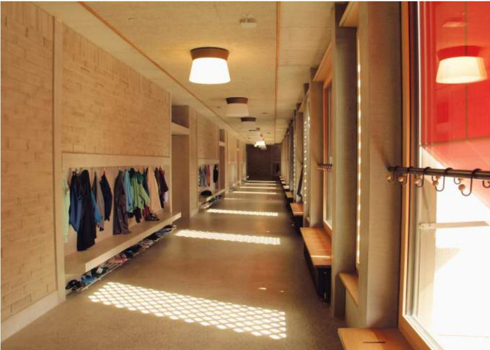
Illustration 1 : nouvelle école du Sacré-Cœur à Estavayer-le-Lac. Maçonnerie de terre crue en remplissage d'une ossature en béton armé. Architectes : Bart & Buchhofer ; Photo © Roman Schirmer
