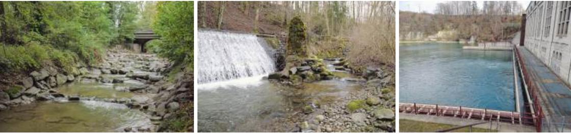
Illustrations 3 : Exemples d'ouvrages de franchissement ; à gauche : Passe à bassins successifs sur le Boiron de Morges ; au centre : Ruisseau de contournement sur le Boiron de Morges ; à droite : Ascenseur à poissons (tour métallique) au barrage de Mühleberg. Photos : © Aurélie Rubin
