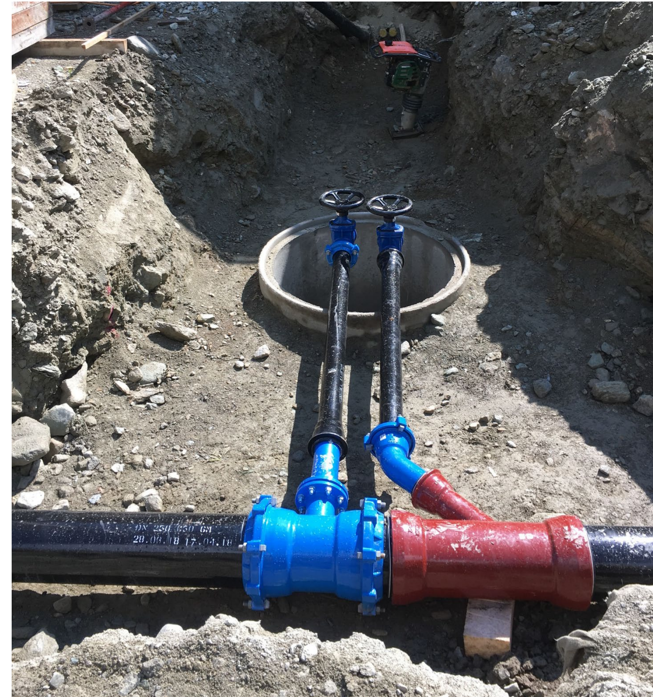
Raccordement du monotube à un bâtiment
