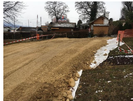
Suivi des mesures de protection des sols
