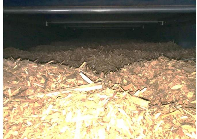
Sur le fond mouvant (capacité de stockage pour une heure d'exploitation des chaudières)
