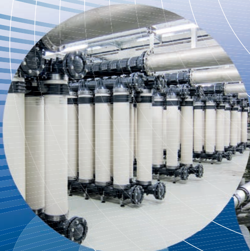
Usine de Sonzier 900 m 3 /h – traitement d'eau de source par ultrafiltration
