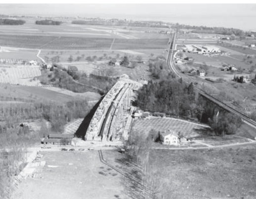
Pont sur l'Aubonne, N1 en construction 1962.
